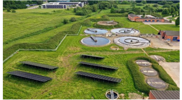
Solcelleanlæg på Odder renseanlæg Foto: Samn Forsyning
