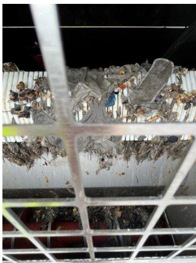
Billede 3 - Midlertidig rist der viser alt det som ikke hører hjemme i et toilet.
