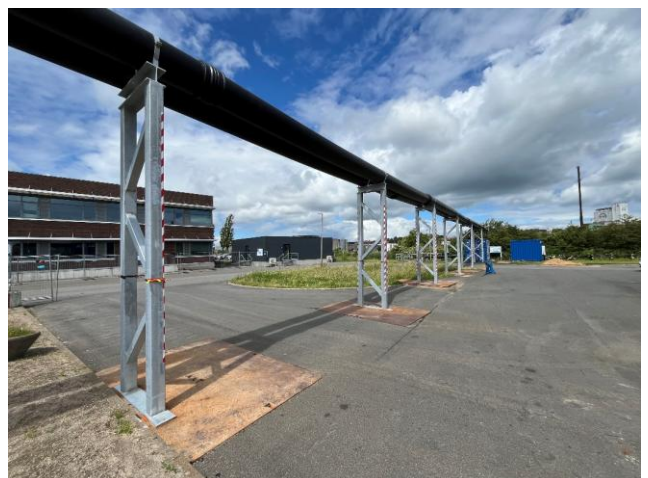
Billede 1 – Midlertidige rør
