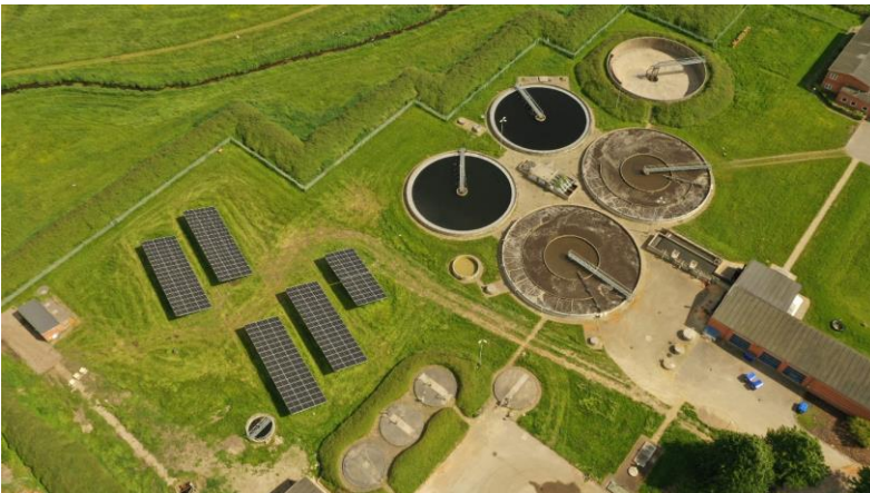
Dronefoto ved Odder Renseanlæg, Samn Forsyning ApS
