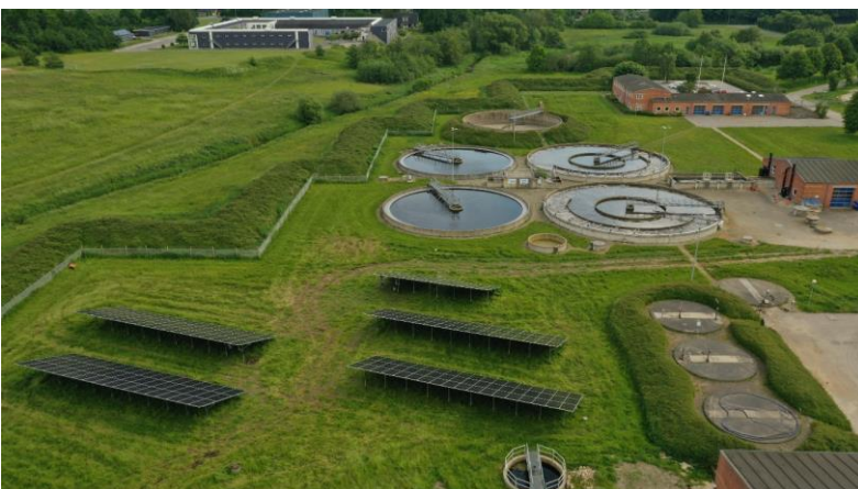
Dronefoto ved Odder Renseanlæg, Samn Forsyning ApS
