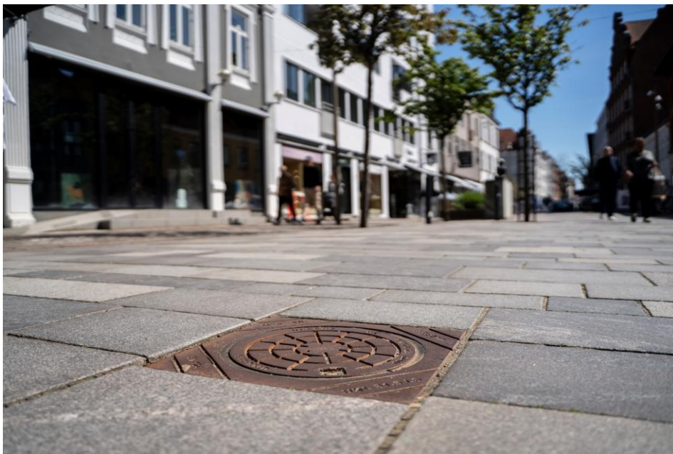
Foto: Samn Forsyning ApS. Kloakdæksel i Søndergade i Horsens
